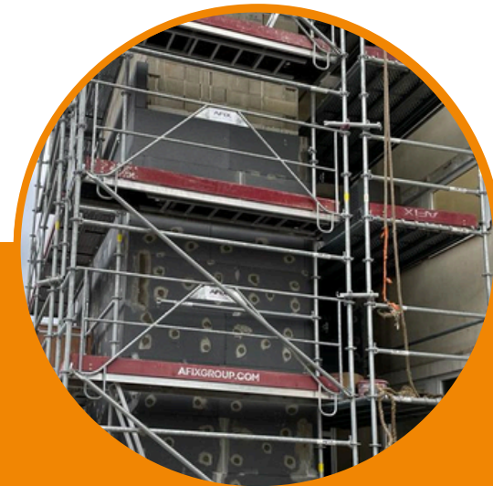
En isolation thermique
